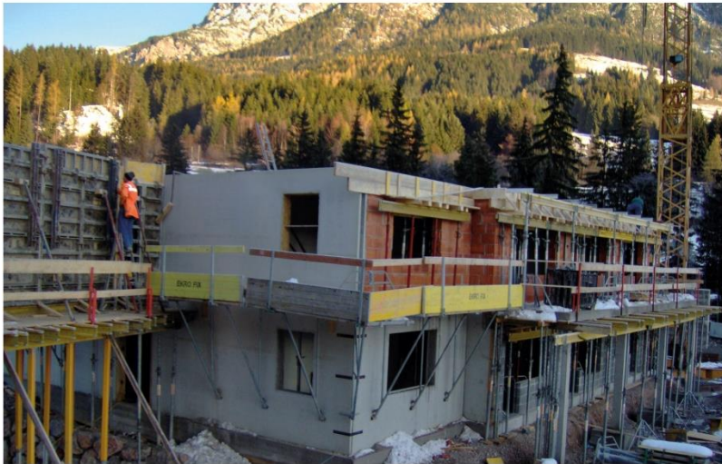
BAU DES SCHMUCKKASTL 28 neue Zimmer und Suiten
